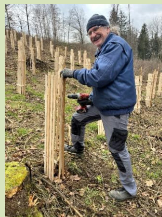
Michael Gebauer bei der Montage des Verbisschutzes © Michael Schlitt
